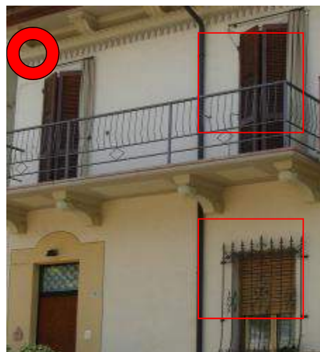
Sebbene in contesto recentemente tinteggiato, senza evidenti elementi di degrado, si denota la presenza di sistemi diversi di oscuramento.
