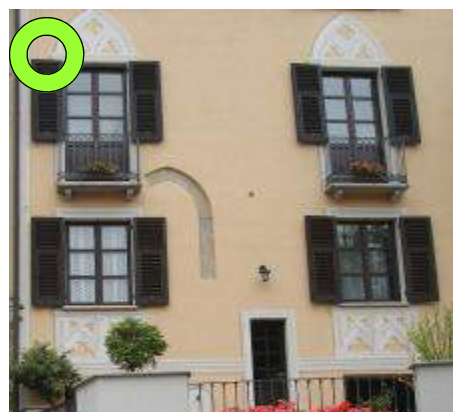
Intervento di restauro di facciata con tutela dei caratteri storici.
