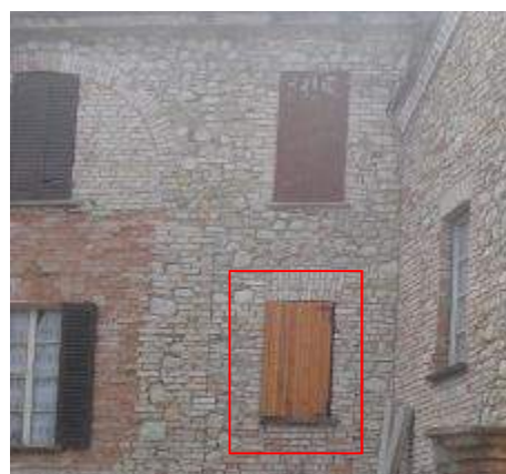
Presenza di sistemi diversi di oscuramento e di diverse coloriture degli stessi
